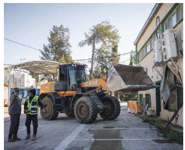
Het gebouw van UNRWA in Jeruzalem vlak voordat het onlangs gesloopt werd.
